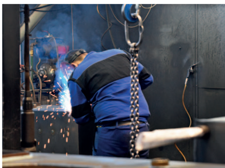
Ručné zváranie kotlov
